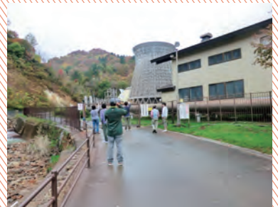
松川地熱発電所の見学風景
