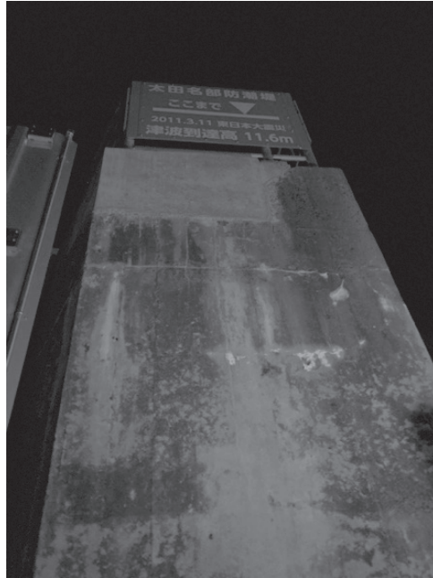
図-9 太田名部防潮堤の津波高さ (撮影：叶、2017年12月17日)
