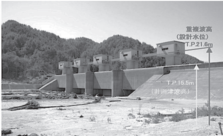
図-8 普代水門全景
