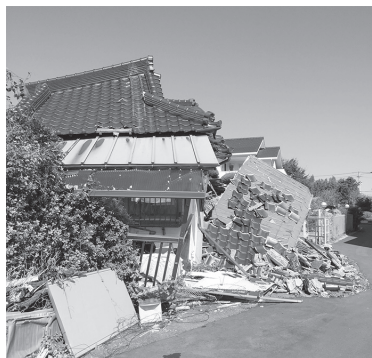
図-5 益城町の被害状況 (2016/10/10 渡部撮影)
