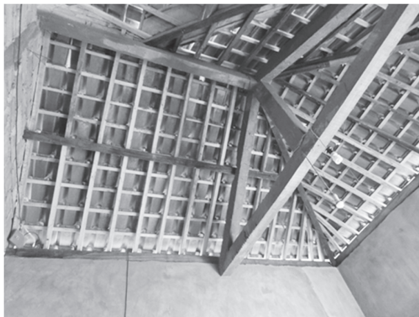
図 8 インドネシアにおける瓦屋根住宅内観例 (2015年11月26日 筆者らが撮影)
