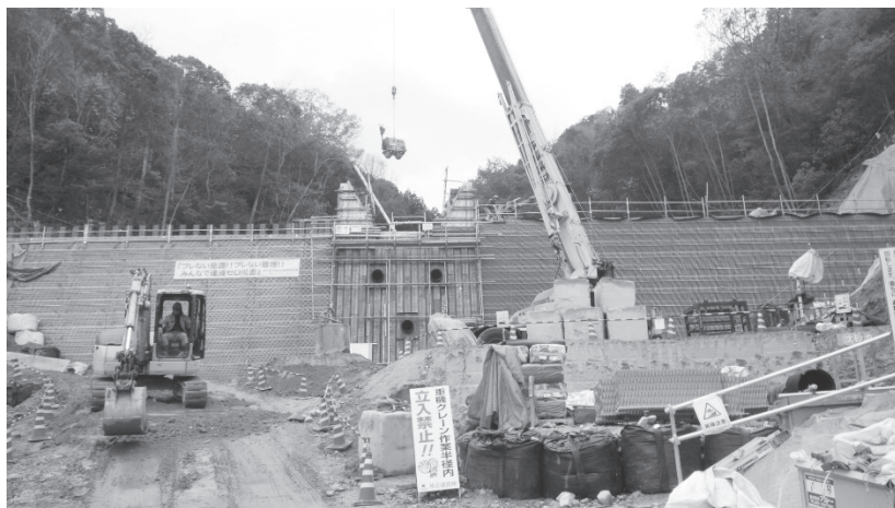
図-7 砂防ダムの建設現場 2015/11/28 中安撮影
