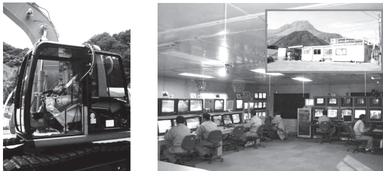
図 1-1 雲仙普賢岳周辺の土砂災害対策工事の無人施工状況 [1]
