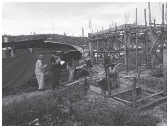
写真14 マラブ沿岸地域建設作業員の男性へのヒアリング
