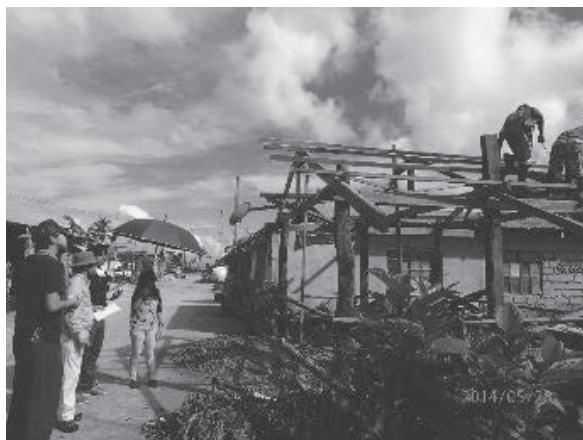
写真13 マラブ沿岸地域のサリサリストア建設現場
