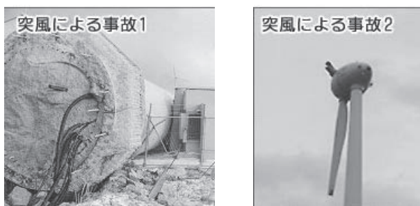
図-19 突風により破壊された設備[39]
