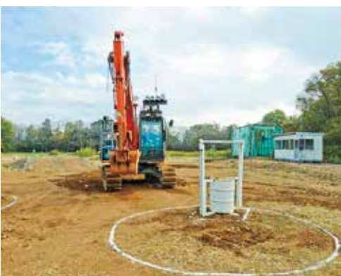
建機の遠隔操縦実験
