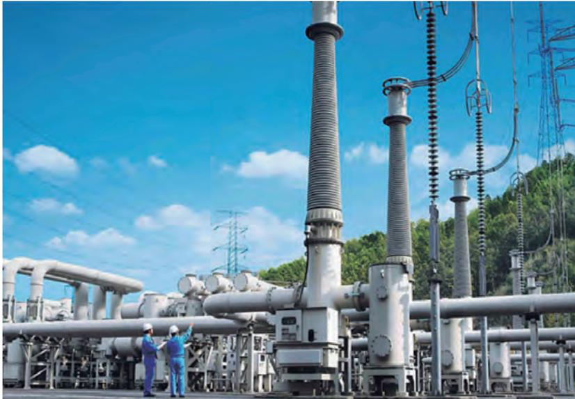
写真左: ガス開閉装置 (Gas Insulated Switchgear: GIS)。
