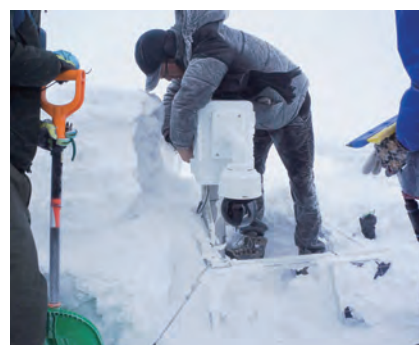
1月20日 外部電源装置のカメラ向きの変更
