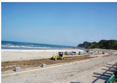
いわき市豊間薄磯地区の防潮堤工事
