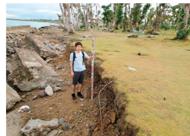
写真1 高潮による堤防の破壊と背後の侵食 (撮影地点:レイテ島バロのマッカーサー上陸記念公園付近)
